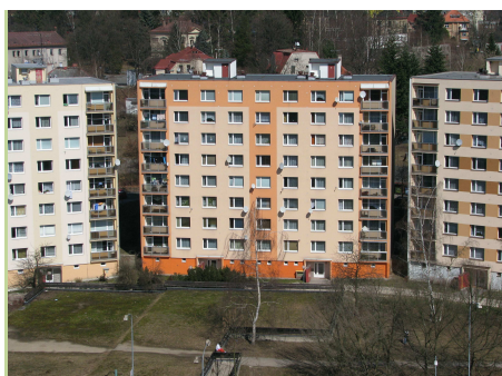
Obrázek 1: Zateplený panelový dům T06B. Zdroj: EkoWATT – Centrum pro obnovitelné zdroje a úspory energie.
